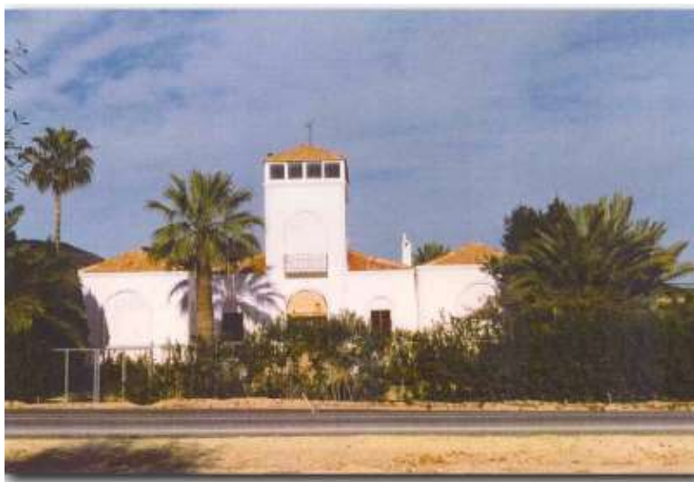
Vista Casa Vistabella al paso de la N340
