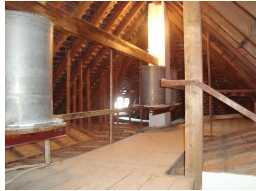
Está formada por jácenas de escuadrillas de grades dimensiones de pino de mobila, correas y parecillos todo del mismo tipo de madera y dónde se sujetan las tejas de pizarra natural con piezas de cinc que hacen de gancho para su encaje y sujeción.
