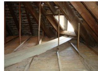
Aun cuando el tejado esté perfectamente construido, la humedad del aire podría tener acceso a su interior. Para evitarlo existen dos salientes, llamados lucernarios (por la iluminación que presta) cuya función es esencial, y que a parte de la ya mencionada, sirve para la ventilación de dicha planta evitando así cualquier condensación de agua, consiguiendo de esta forma disponer de una cámara de aire bajo la cubierta de pizarra.
