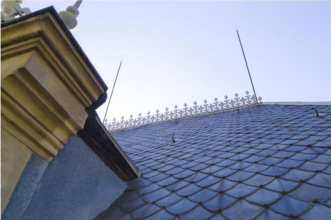
La pizarra es una roca homogénea, de grano muy fino, comúnmente de color negro azulado, opaca, tenaz y que se divide con facilidad en hojas planas y delgadas. Procede de una arcilla metamorfoseada por las acciones telúricas, que troceado cortado y laminado se emplea, entre otros, para techar o tejar.
