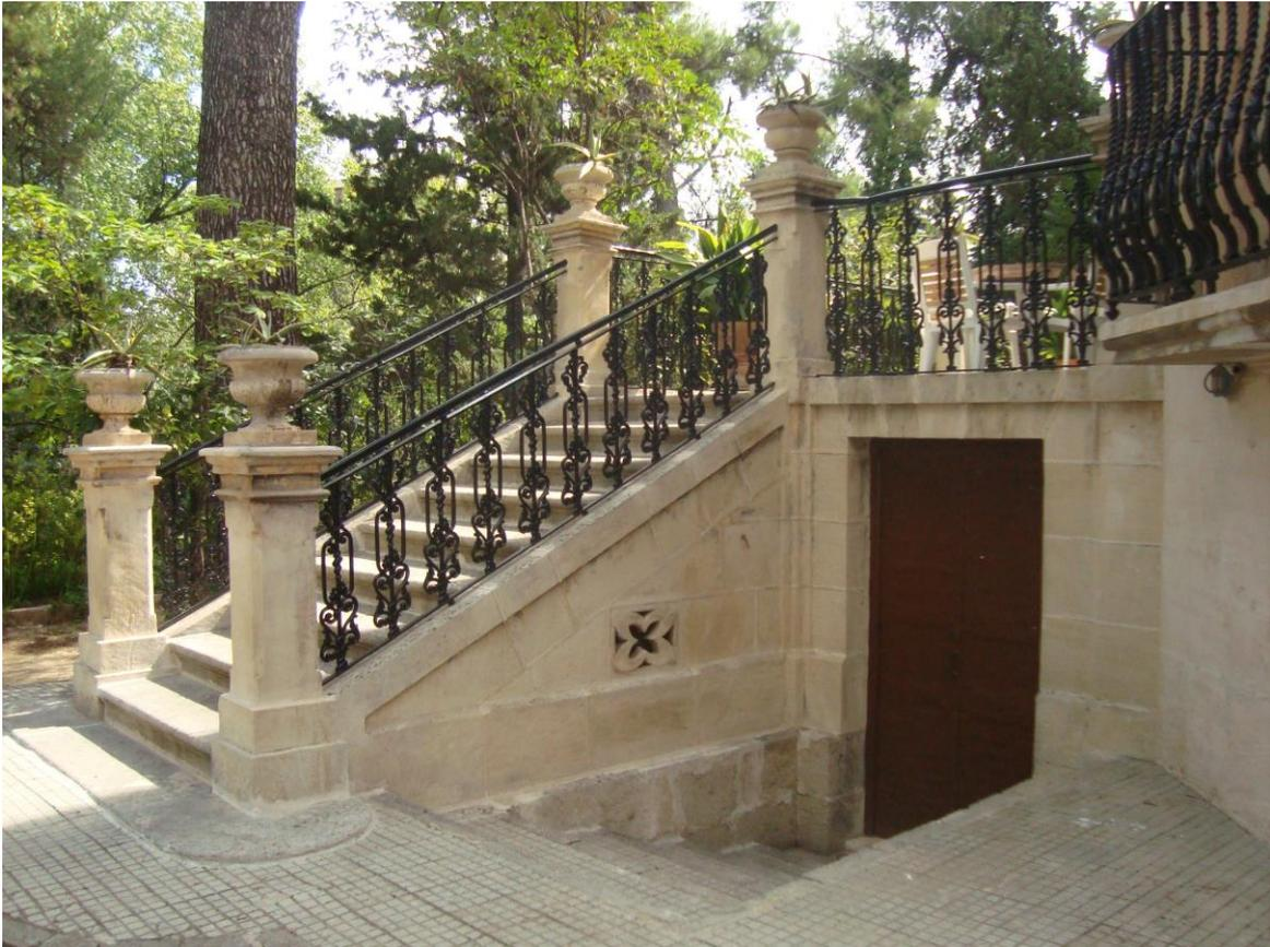
Tiene, como terraza en altura, una barandilla de hierro forjado modernista sujeta por ocho pilares, de los cuales cuatro forman también parte de la sujeción de la barandilla de las dos escalinatas existentes. Éstas, formadas por sillares de piedra caliza de grandes dimensiones, están situadas en ambos extremos de la terraza permitiendo el acceso desde el jardín a la misma o viceversa.
