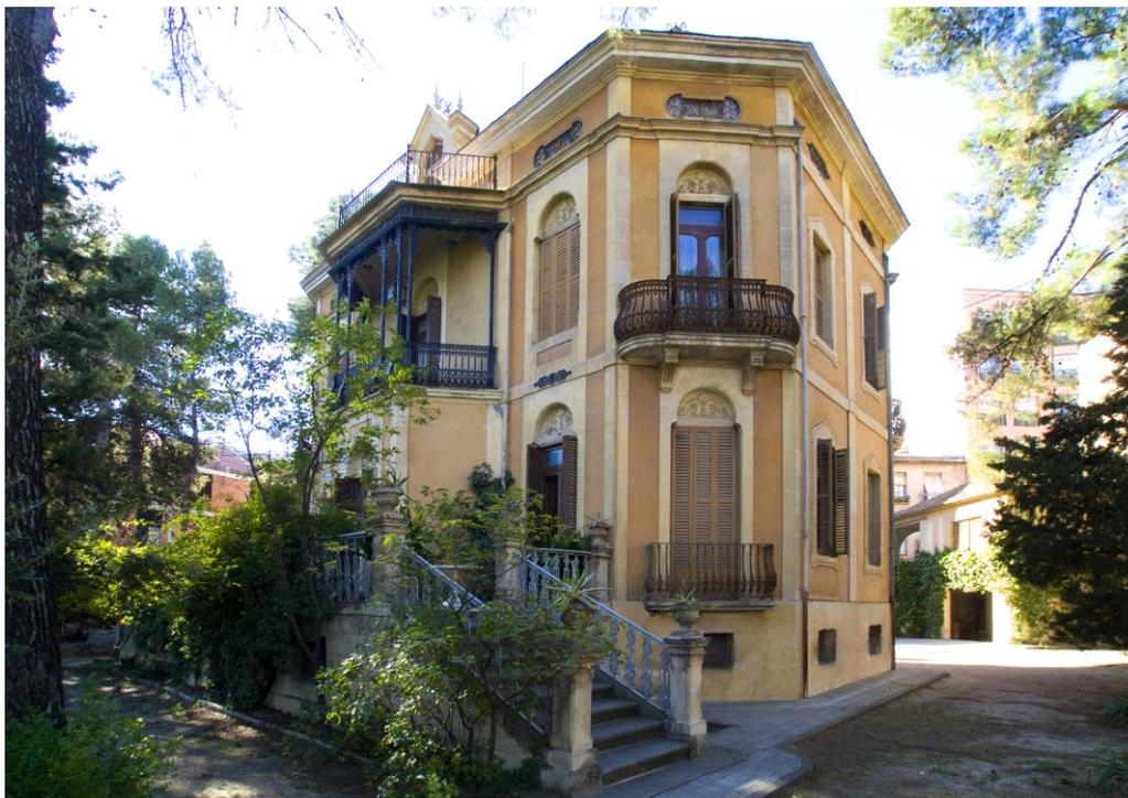
Finalmente y en cuanto a las fachadas, comentar las bajantes de cinc colocadas simétricamente en los laterales de éstas que recogen y canalizan el agua de lluvia de la cubierta. Son vistas y se acoplan, antes de llegar al suelo, a una tubería de hierro forjado a la altura del zócalo de sillar que rodea el edificio y en su parte superior están empotradas en fachada.
