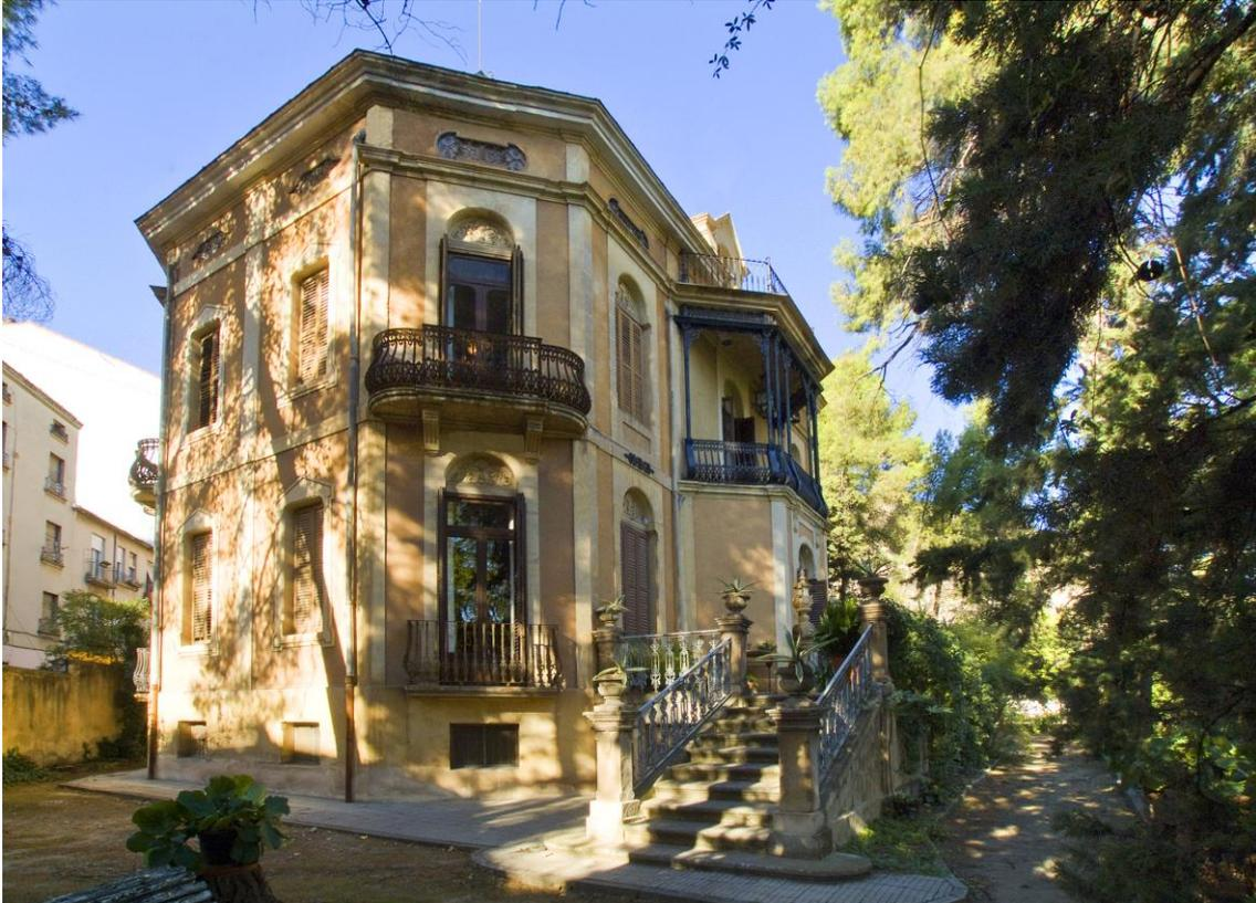
Las ventanas que dan a la planta baja de la vivienda están enclavadas en el mencionado zócalo de sillería que parte de la acera que se alza aproximadamente sobre la rasante del terreno unos diez centímetros (10,00 cm) y empiezan, sobre ésta, a una altura de cuarenta y cinco centímetros (45,00 cm) con un entrante de veintidós centímetros con cincuenta milímetros (22,50 cm), formando una pequeña pendiente para evitar la entrada de agua de lluvia.
