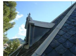
El grado de inclinación de la cubierta es elevado y de ahí el grado de complejidad de su realización, pero el beneficio para la edificación es enorme, ya que cuanto mayor es la inclinación con más rapidez se desliza el agua de lluvia e impide el estancamiento de ésta en la cubierta lo que ayuda considerablemente a evitar la aparición de goteras.
