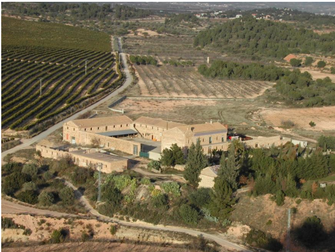
Complejo de edificios de la Masía del Juez, en el término municipal de LLiria.
