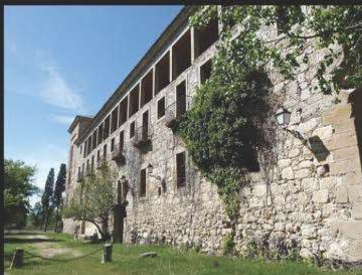
Vista de la fachada principal
